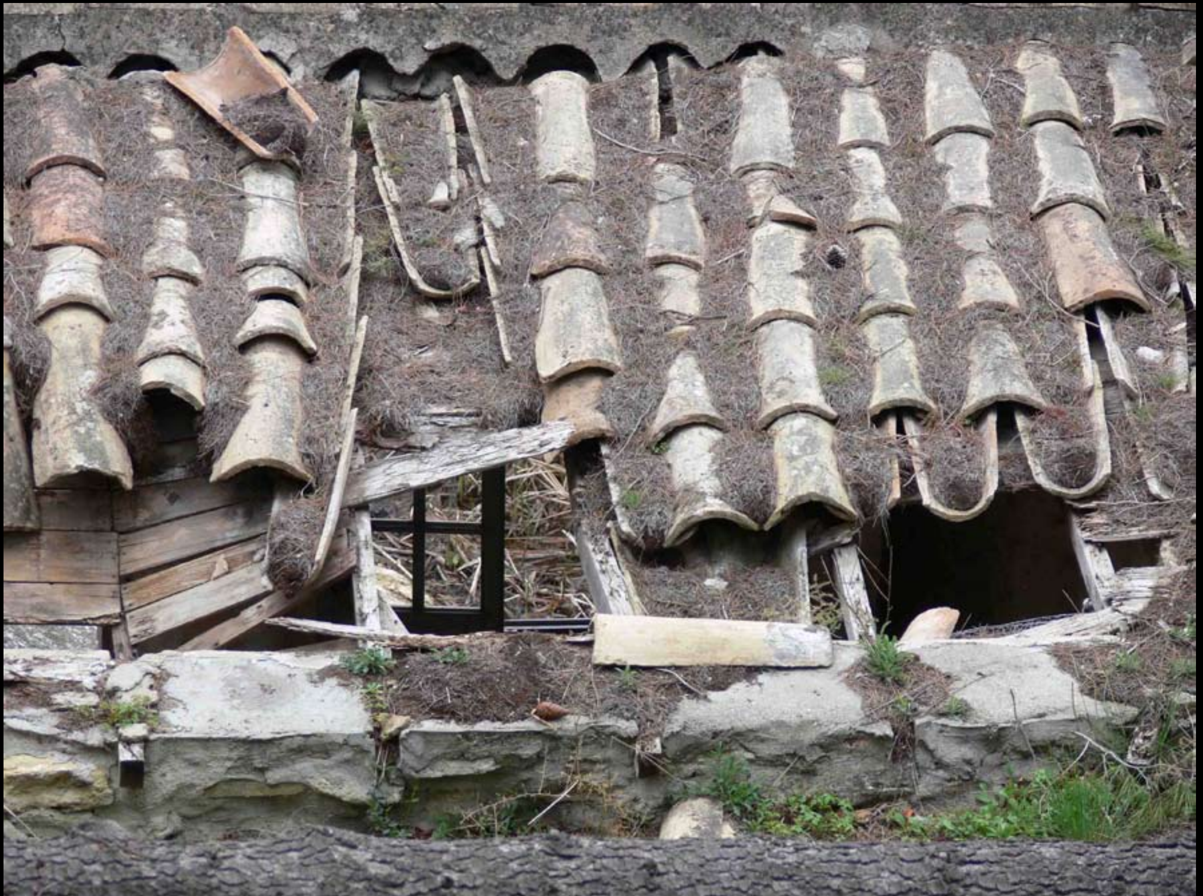
altes Dach in St. Remy
